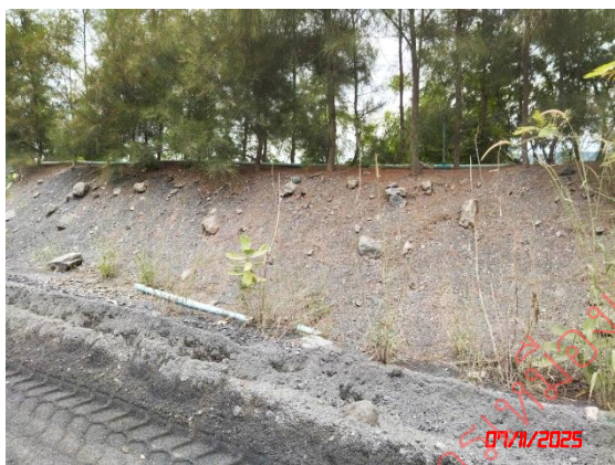
รูปที่ 15 คันทันดิน และคูระบายน้ำ
