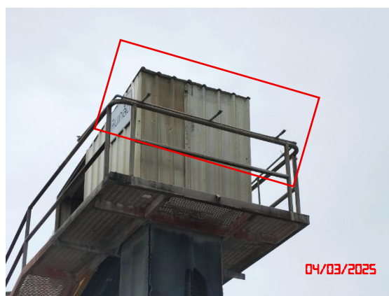
ระบบสเปรย์น้ำบดสายพานลำเลียง
